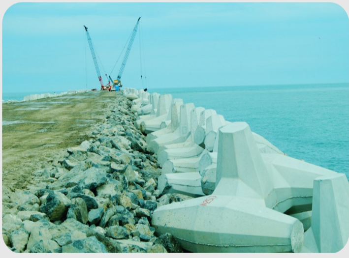
Instalación de piezas core-loc en las escolleras
