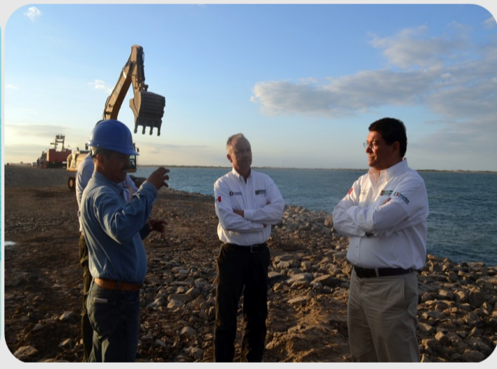
Visita de obras
