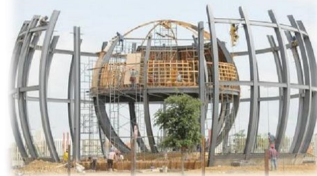
Estructura de la construcción de La Casa de la Tierra
