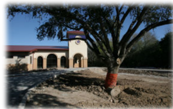
Edificio en construcción del Valley Nature Center
