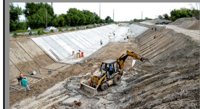
Obras de revestimiento, en 2013
