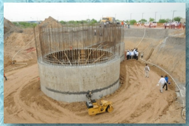
Construcción de la PTAR 2, en Matamoros
