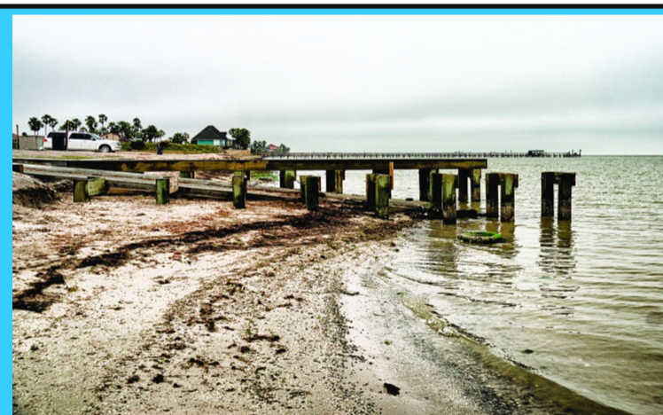
La nueva rampa –inconclusa– para hidrodeslizadores
