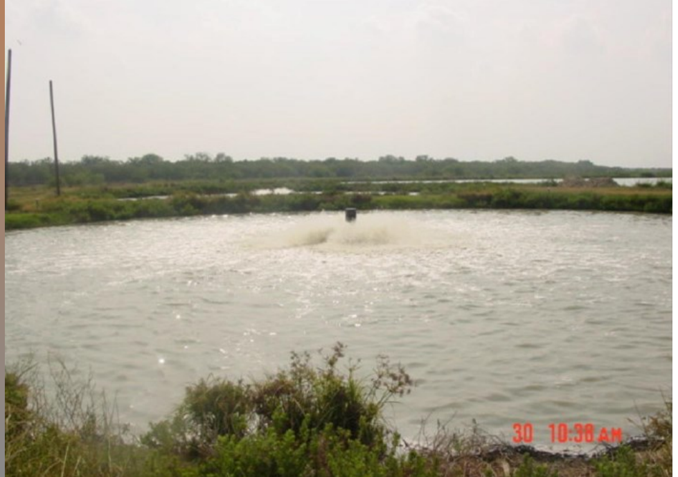
Sistema de lagunas de la planta tratadora de aguas residuales
