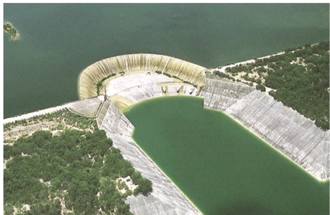
La presa Marte R. Gómez Fuente: La Tarde
