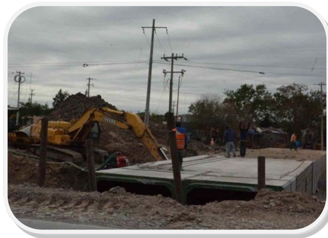
Avance de las obras del sifón hidrológico (febrero 2020)
