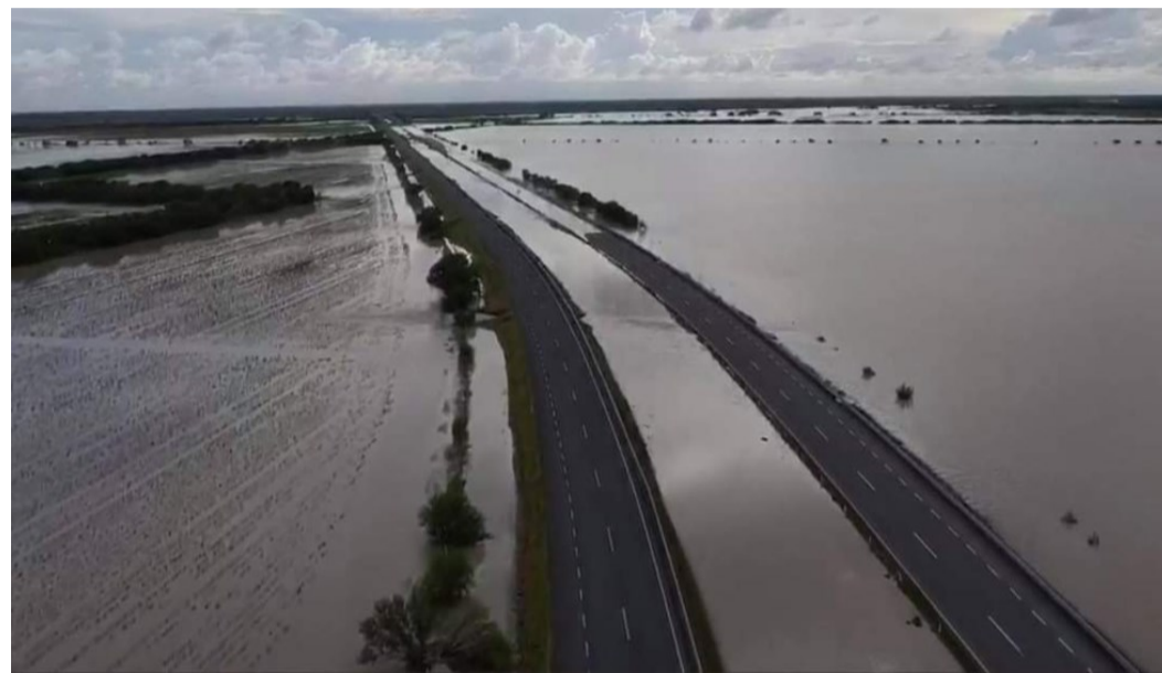
La carretera de cuota Matamoros-Reynosa (en el centro lo cruza un dren) y el área inundada, cerca de Nuevo Progreso
