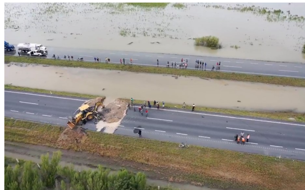
Obras de ruptura de la carretera
